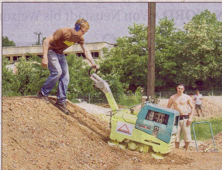
Georg Behr (vorn) und Christian Koch arbeiten am künftigen Fahrradparcours an der Franklinstraße.
